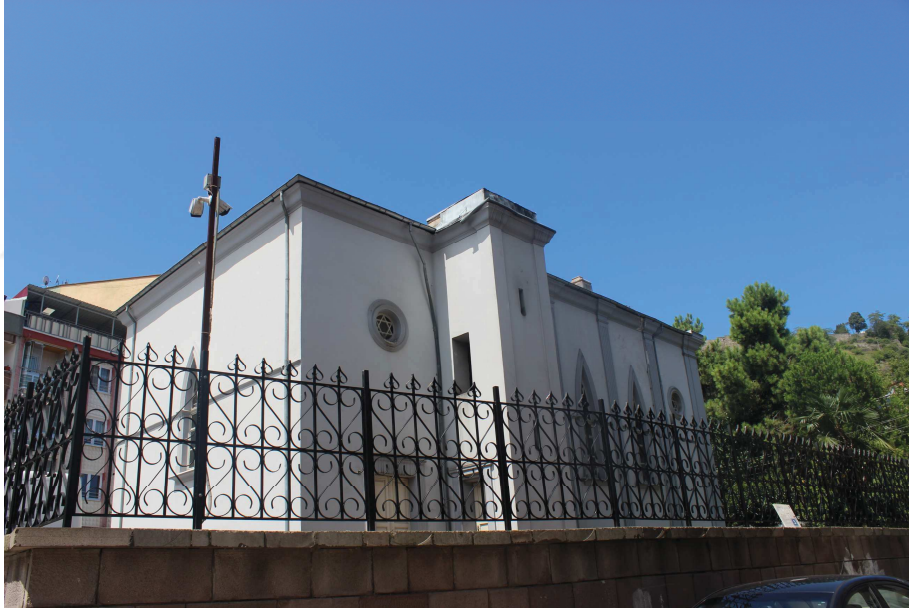
Resim 74 : Kapusen Katolik Kilisesi Kuzey Cephesi
