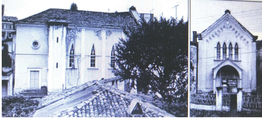
Resim 71 : Kapusen Katolik Kilisesi Tarihi Görünüm ( T. Dervişoğlu Arşivi 1990 ) 305
