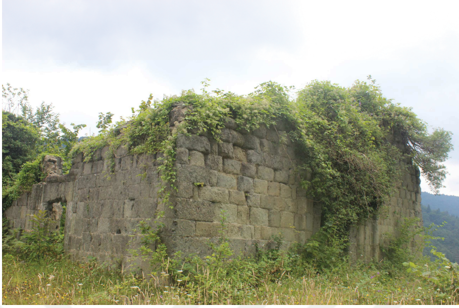
Resim 45 :Karaali Köyü Kilisesi Genel Görünüm 4
