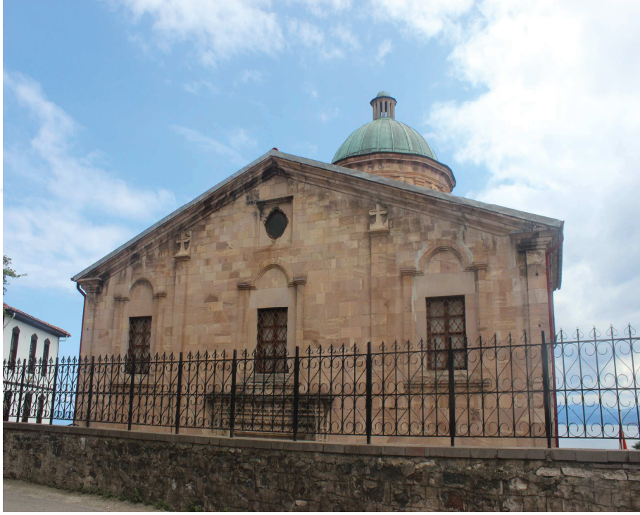
Resim 6: Gogora Kilisesi Güney Cephe
