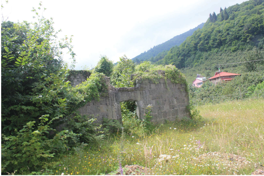
Resim 42 : Karaali Köyü Kilisesi Genel Görünüm 1
