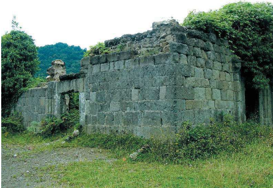
Resim 52 : Karaali Köyü Kilisesi 295
