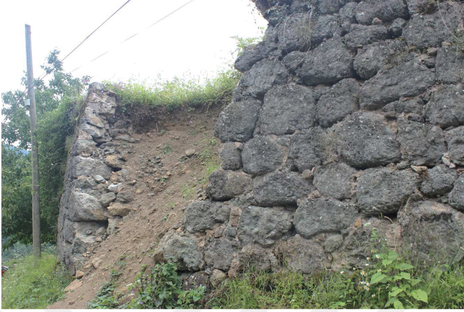
Resim 47 : Karaali Köyü Kilisesi Avlu Duvarı Görünümü 2
