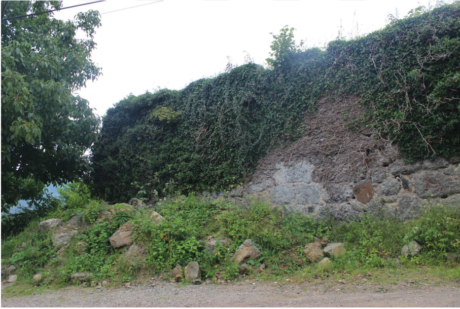
Resim 48 : Karaali Köyü Kilisesi Avlu Duvarı Görünümü 3
