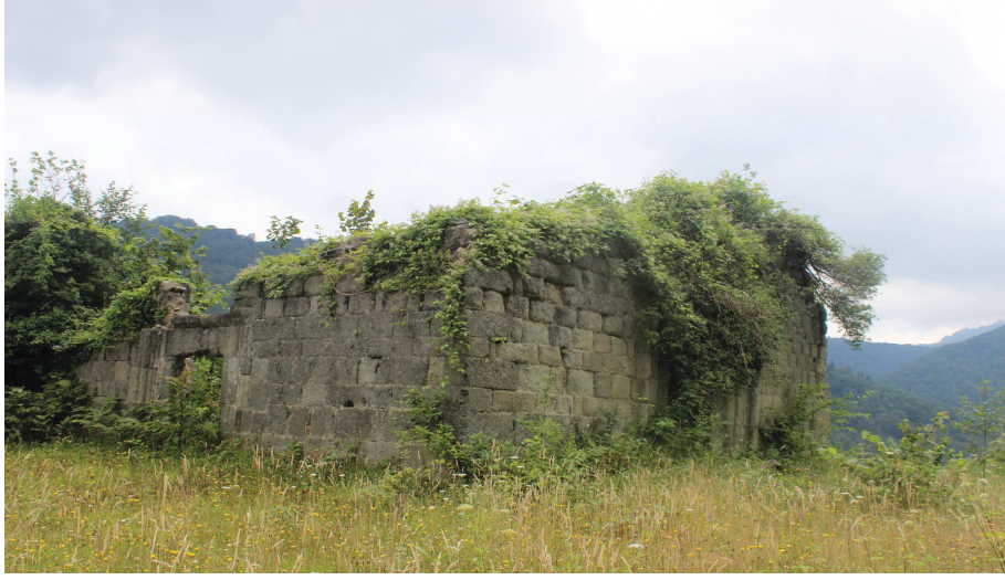
Resim 43 :Karaali Köyü Kilisesi Genel Görünüm 2
