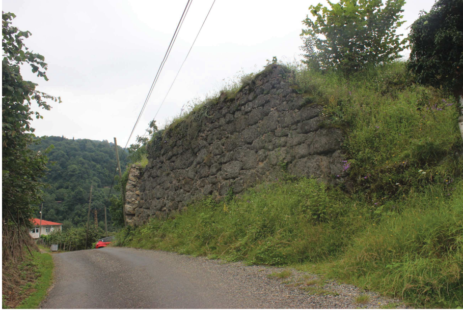
Resim 46 :Karaali Köyü Kilisesi Avlu Duvarı Görünümü 1
