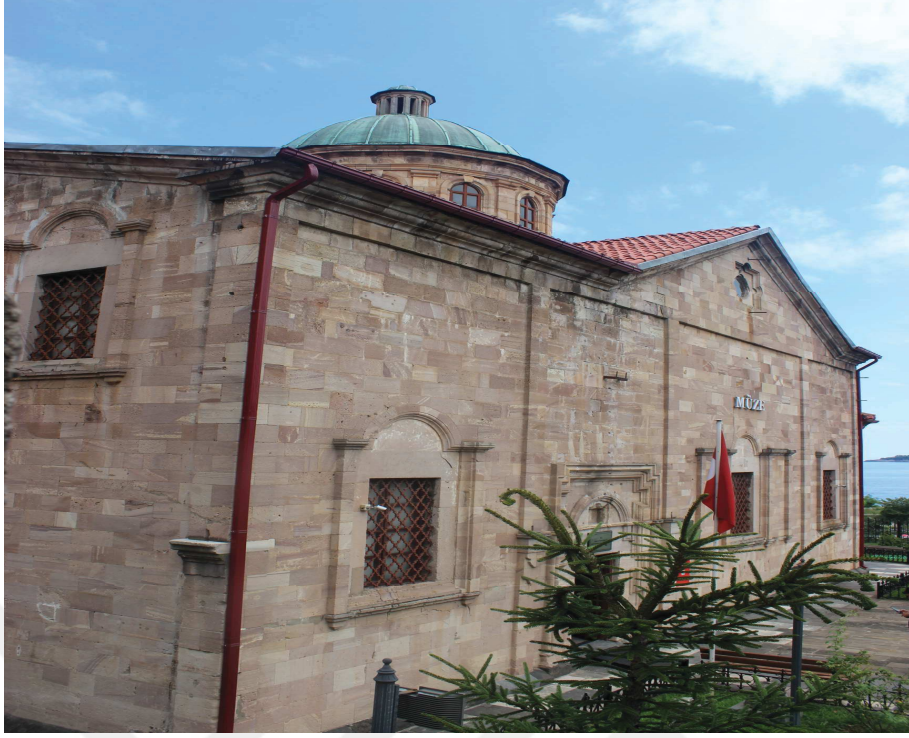
Resim 9 : Gogora Kilisesi Batı Cephe
