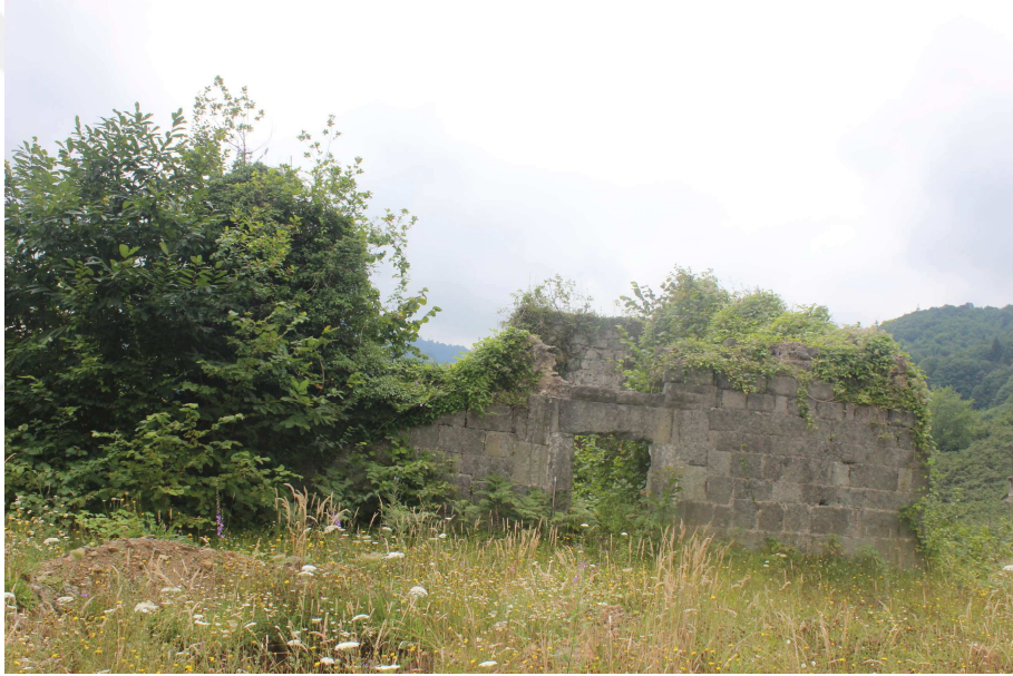
Resim 44 :Karaali Köyü Kilisesi Genel Görünüm 3
