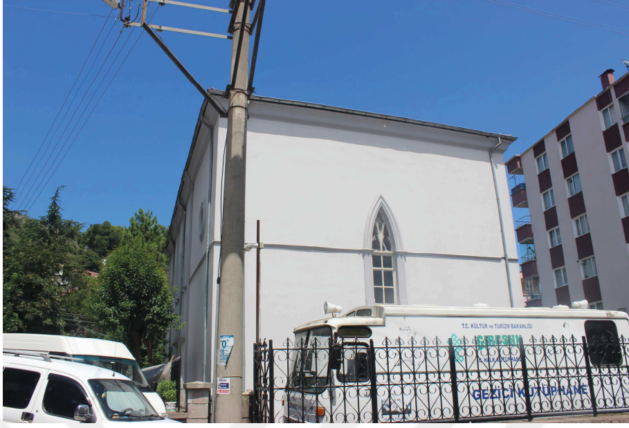
Resim 73 : Kapusen Katolik Kilisesi Doğu Cephesi
