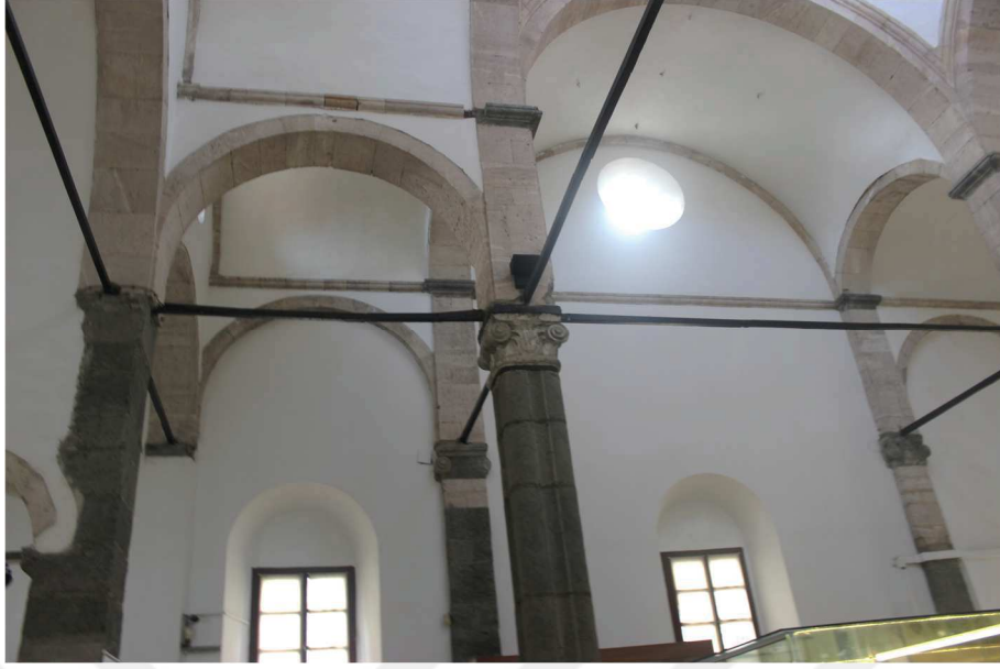
Resim 25 :Gogora Kilisesi İç Mekan 4
